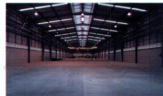
Metade das paredes foi executada em blocos de concreto. A outra parte teve venezianas comoventes, que permitem ventilação no ambiente, e telhas trapezoidais. O próprio cliente foi fornecedor de materiais para a construtora, reduzindo custos e promovendo o produto
