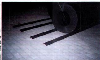
O piso intertravado foi empregado no setor de armazenamento de bobinas. O sistema se deforma, não se rompendo com o peso do aço. Para regularizar o piso, os blocos afundados são retirados, coloca-se areia compactada para preencher o espaço e as peças são recolocadas
